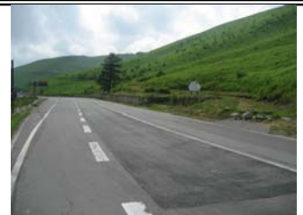
色の濃い走行車線に溝が刻まれている。
